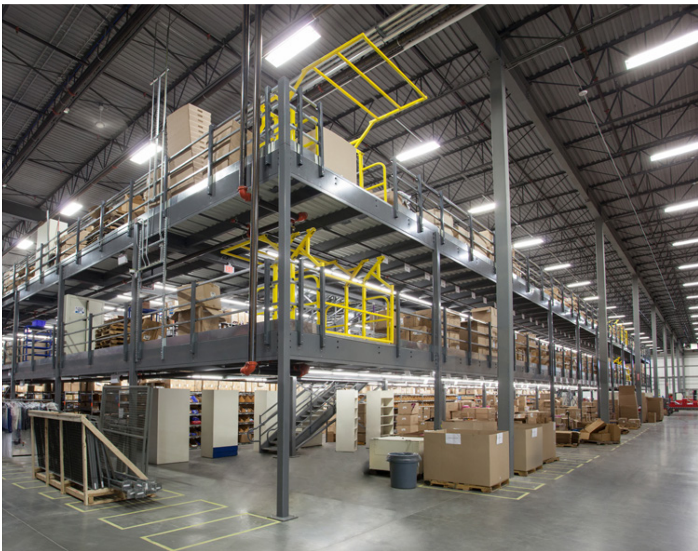
Photo : Mezzanine de centre de distribution en ligne
