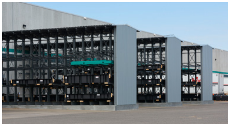
Photo : Remises avec rayonnages en porte-à-faux pour l'entreposage extérieur
