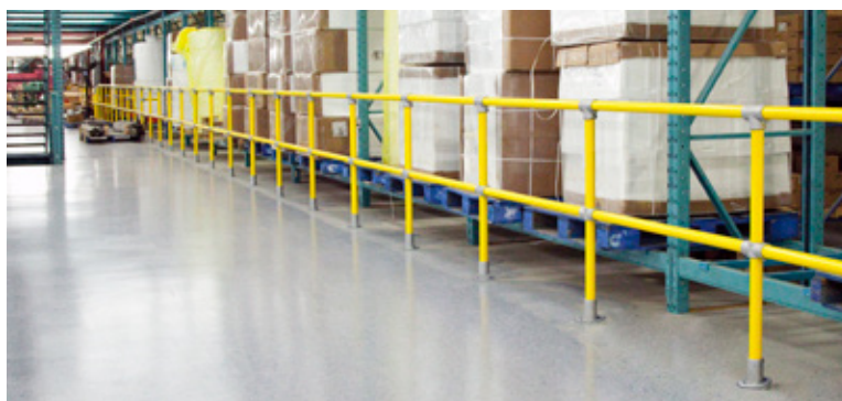
Photo : Barrières de contrôle de la circulation des piétons
