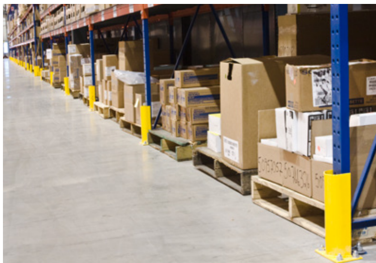
Photo : Garde-poteau de rayonnage
