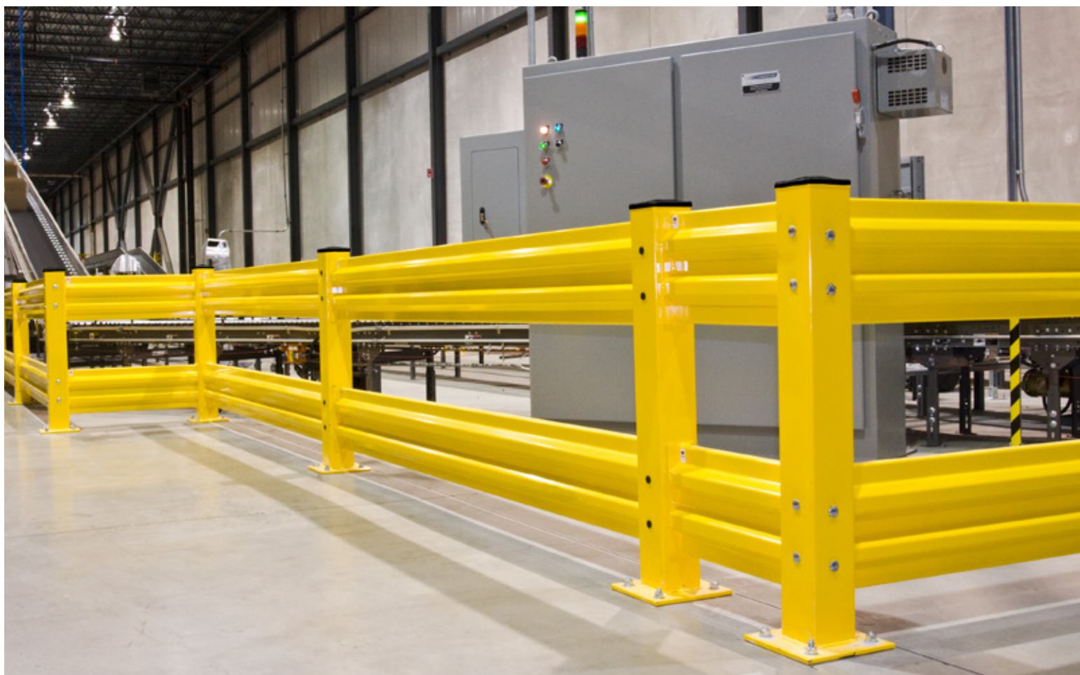
Photo : Parapet de protection de panneau électrique à rail double
